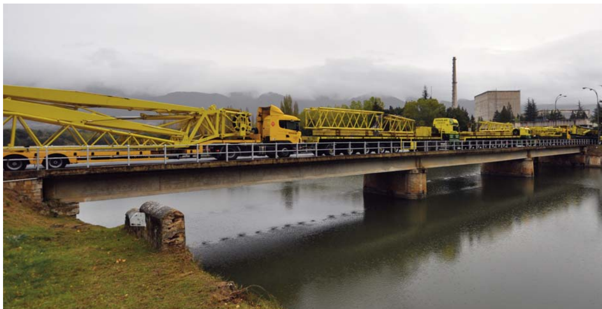
El equipamiento necesario para realizar los trabajos a su llegada a la Central Nuclear de Santa María de Garoña.
